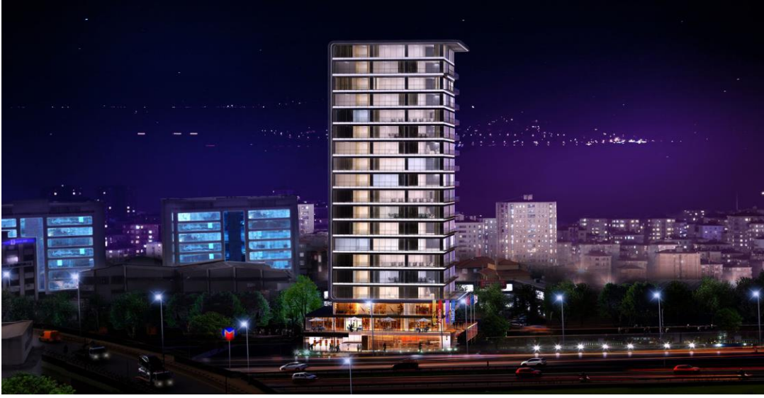
DUMANKAYA METROWIN TOWER HVAC ve MEKANİK TESİSAT UYGULAMALARI
