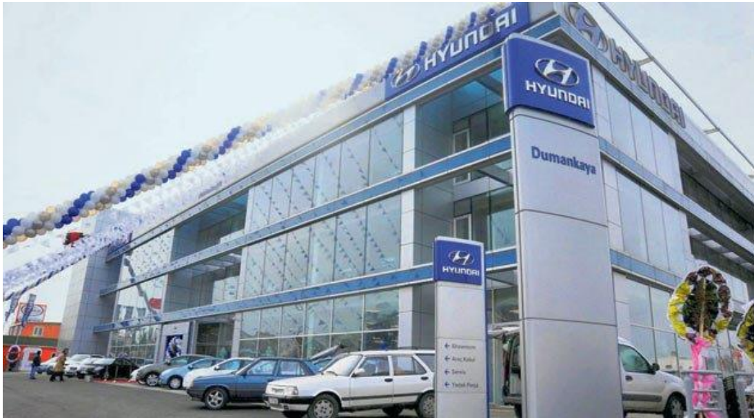
DKY HYUNDAI PLAZA HVAC ve MEKANİK TESİSAT UYGULAMALARI
