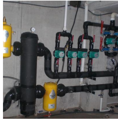
SIHHİ MEKANİK TESİSAT UYGULAMASI
