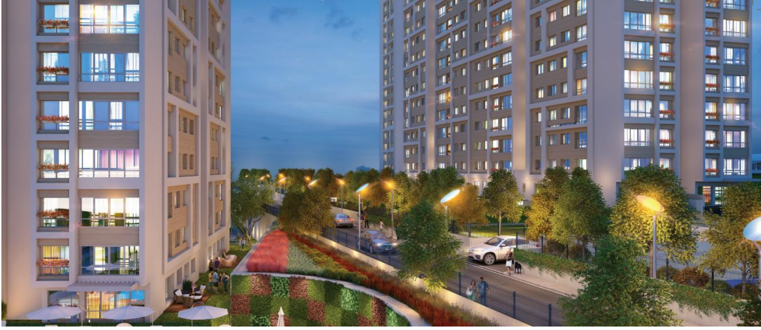
DUMANKAYA LOKUMEVLER HVAC ve MEKANİK TESİSAT UYGULAMALARI
