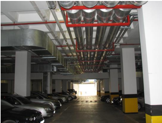
DUMANKAYA-KONSEPT HVAC VE MEKANİK TESİSAT UYGULAMALARI
