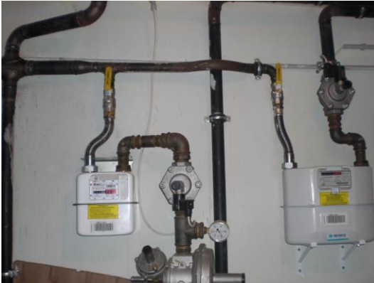
DOĞALGAZ TESİSATI UYGULAMASI
