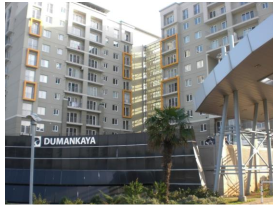
DUMANKAYA-TREND HVAC VE MEKANİK TESİSAT UYGULAMALARI
